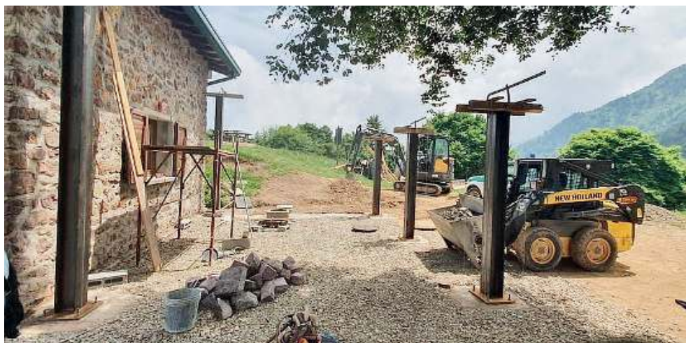
A 1.500 metri. Lavori al rifugio di proprietà del Comune: verranno realizzati nuovi porticati
