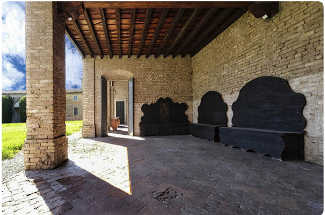
il porticato interno del corpo centrale
